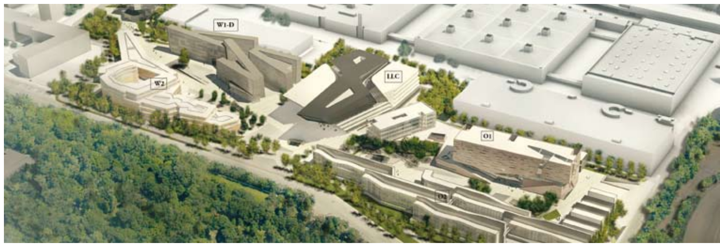
Projekte vorziehen und Baukonjunktur ankurbeln: Campus der Wirtschaftsuniversität Wien. Projektgemeinschaft WU und Bundesimmobiliengesellschaft (BIG), Generalplaner: BUSArchitektur und Vasko + Partner. Fotos: BOAnet.at
