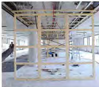
Die Einbauten für die Kollaborationszone wurden in Trockenbauweise erstellt
