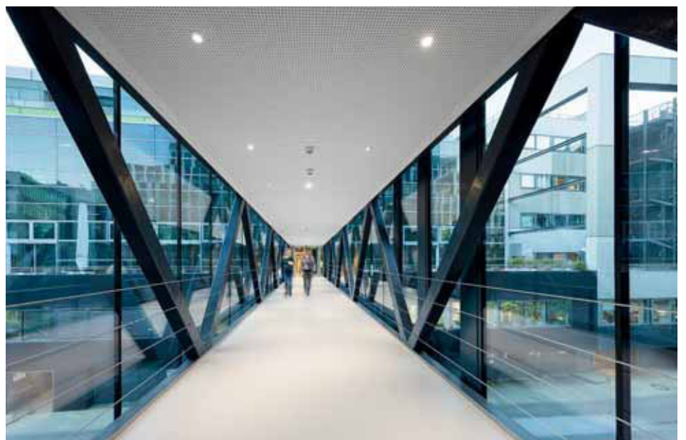
Den Neubau des IMP verbindet eine Brücke im zweiten Obergeschoss mit dem ehemaligen, mittlerweile sanierten IMBA sowie dem GMI (hinten im Bild).
