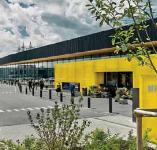
Die gelbe Eingangsbox ist signifikant für die neue Supermarkt-Generation von Edeka.
