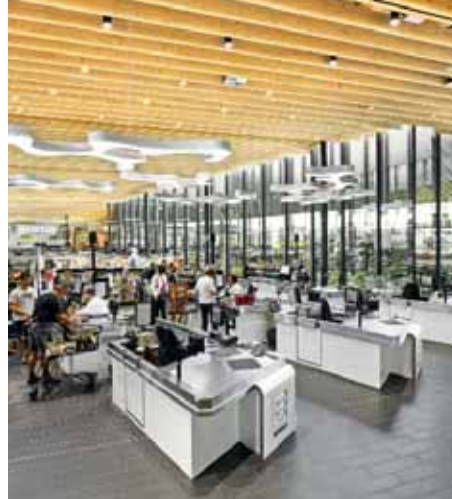
Der Marktbereich wird von Brettschichtholzbindern im Abstand von 8 m überspannt, die bis zu 17 m frei tragen.
