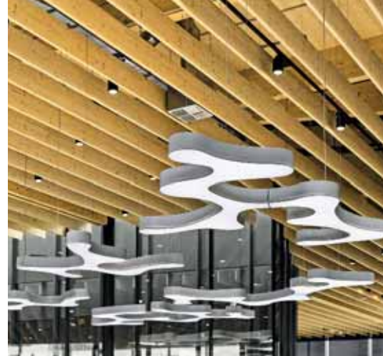
Die Lamellenstruktur verleiht der großen Deckenfläche einen weichen Verlauf und zieht sich fließend von innen bis ins auskragende Dach. Dazwischen ist die darüberliegende Holzkonstruktion sichtbar.
