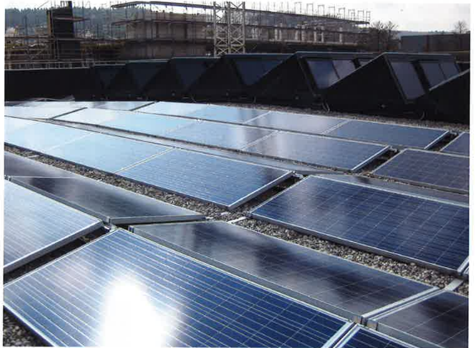
Die Dachflächen sind komplett mit Wolfin M abgedichtet: Flachdach mit Sheddachfenstern und umlaufender Attika als Wind- und Sichtschutz.
