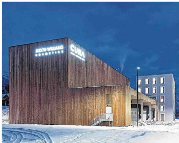
Im Vordergrund das Konfektionierungs- und Logistikgebäude von Cura als Holzbau im Lärchenholzkleid, im Hintergrund der Bürokomplex als Kubus.
