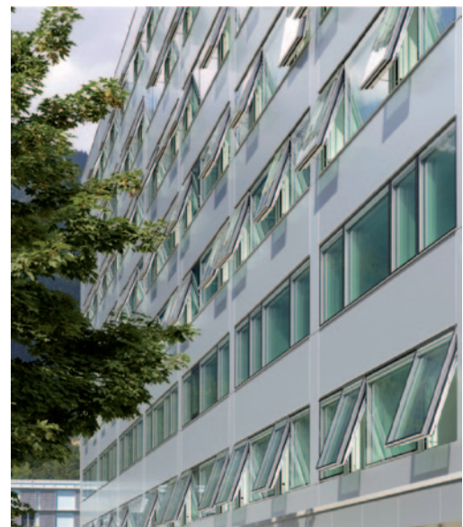
Abb. 1: Fassade mit Senk-Kipp-Verbund-Fenster Quelle: ATP/Thomas Jantscher
