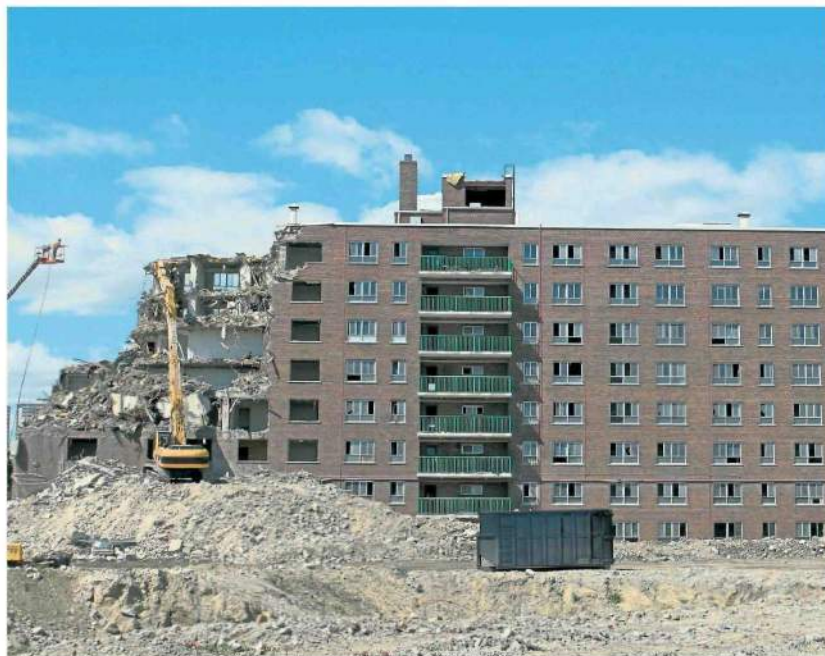
„Reconstructing“ nennt sich der Vorgang des Abbruchs eines Altbaus samt folgender Neubebauung desselben Grundstücks. Das Einsparpotenzial beim Heizwärmebedarf ist im Regelfall enorm.
