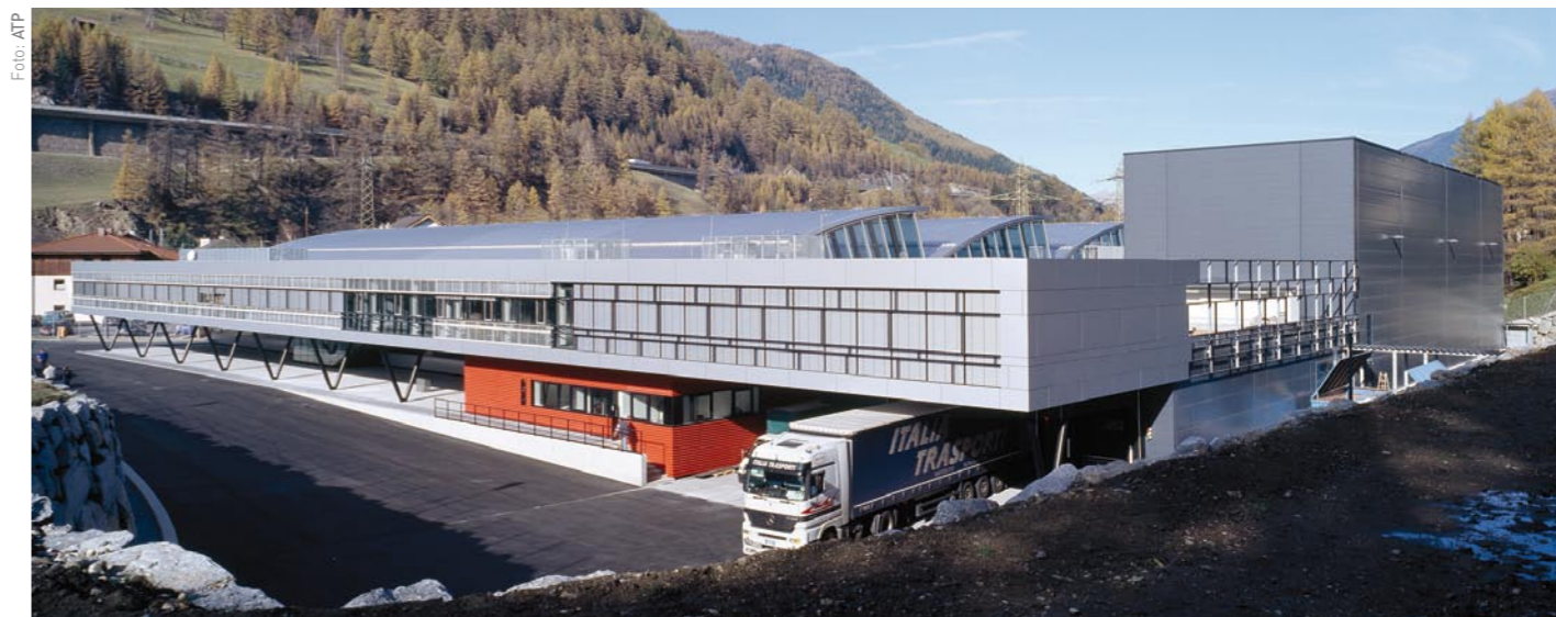
Vorzeigeprojekt: ATP realisierte im Wipptal das GWM Gerätewerk Matrei, bestehend aus Produktionshalle und Hochregallager.
