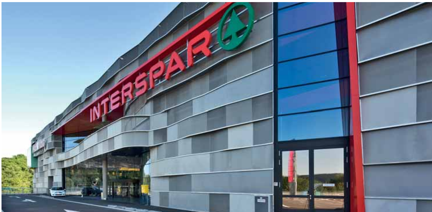
Shopping Center VARENA: Die Hauptfassade nach Norden hin präsentiert sich als silbergraue Stickerei, die das Licht je nach Intensität entsprechend reflektiert.
