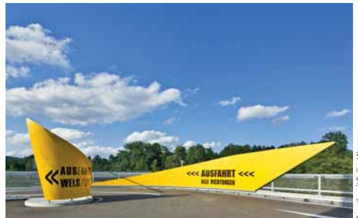
Die Ausfahrt des Parkbereiches artikuliert sich in auffälligem Gelb.
