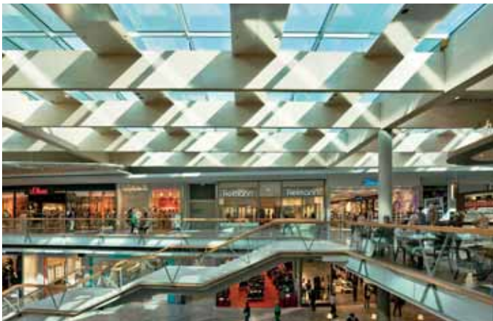
Durch den Lichteinfall erscheinen die Holzbinder leicht.
