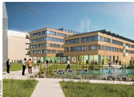
Neuester Auftrag ATP hat die erste Baustufe des Technologiezentrums in der Seestadt Wien-Aspern gewonnen
