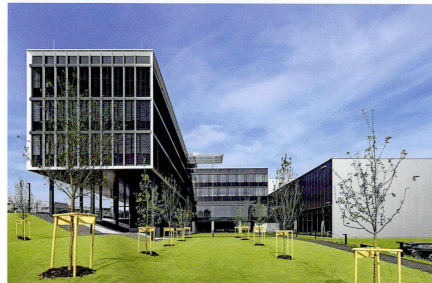
Die Gebäudeplanung und -bewirtschaftung umfasst den gesamten Lebenszyklus.
