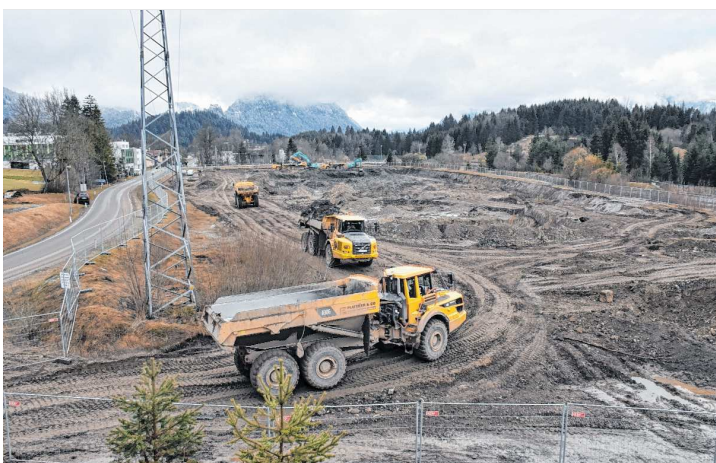
Der Aushub der Industriefläche beim Kreckelmoos wird in die naheliegende Deponie Hurt gebracht. Foto: Mittermayr
