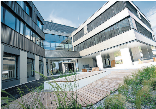
Bauteil 2 von fünf geplanten ist fertig. Über Spiegel wird das Atrium natürlich beleuchtet. Im Erdgeschoß und im ersten Obergeschoß wurde die Tragfähigkeit der Decken verstärkt.
