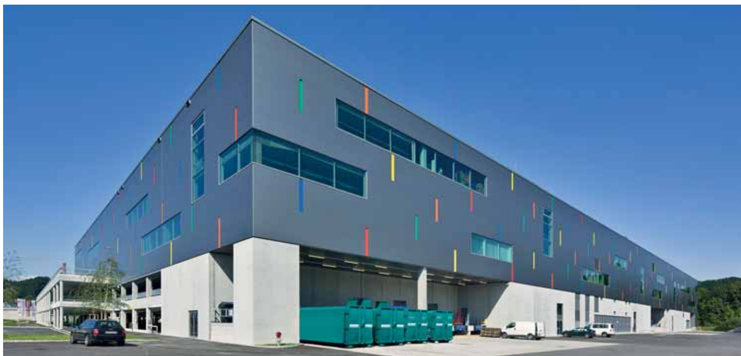
Die Sandwichpaneelfassade wurde so verarbeitet, dass die vertikalen Stöße nicht sichtbar sind.
