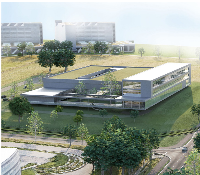
Betriebs- und Forschungsgebäude des System- und Softwarehauses der AEG
