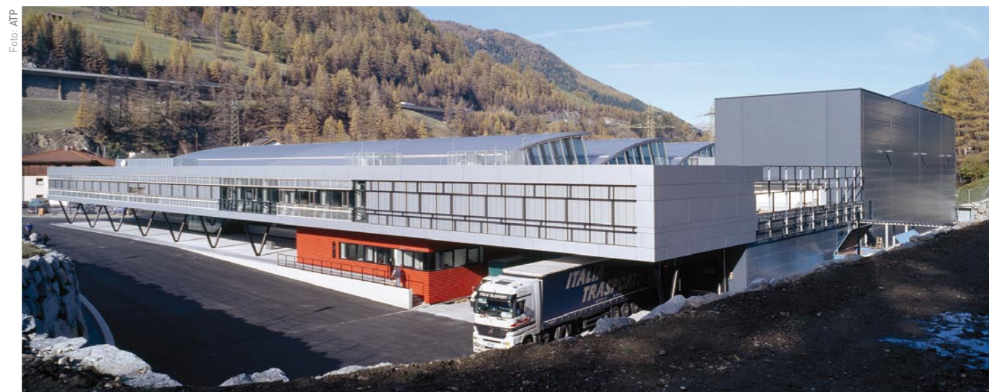
Vorzeigeprojekt: ATP realisierte im Wipptal das GWM Gerätewerk Matrei, bestehend aus Produktionshalle und Hochregallager.
