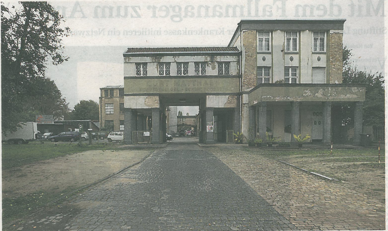
Begehrtes Gelände: Das Areal der ehemaligen Maschinen- und Metallwarenfabrik in der Bieberer Straße.
