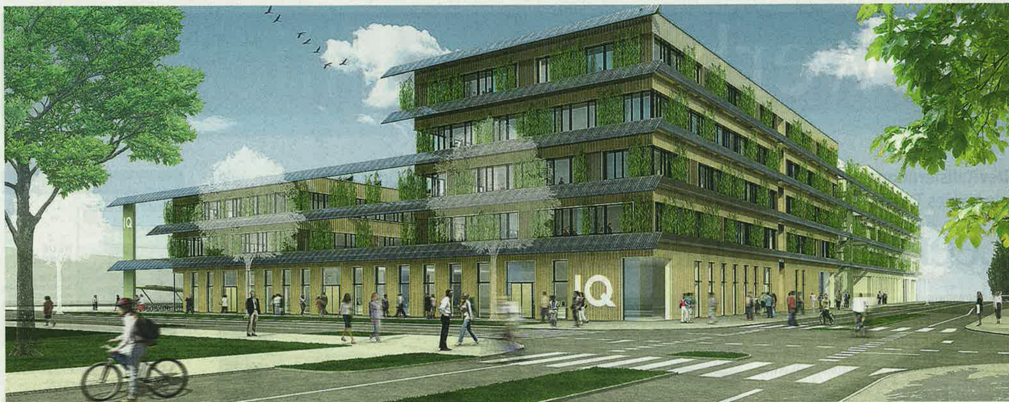
Die Betriebsansiedlung Aspern IQ ist noch im Entstehen – und wird als „grüner“ Bau mehr Energie erzeugen, als sie benötigt.
